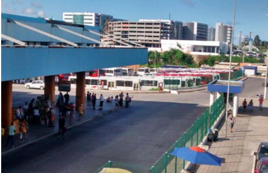
Figura 3: Terminal de Ônibus Mussurunga
